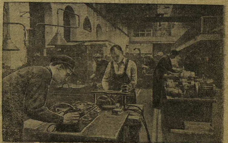
На снимке: Комсомольцы-монтажеры С. Ефимов (слева) и Э. Касс за испытанием новых электромоторов.
